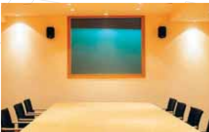
Konferenztechnik: Von der einfachen Projektion bis zur AMX Raumsteuerung mit Multimedia und Monitoren.
